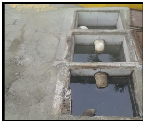
Fig. 34 Trampa de grasa E/S SAN CLEMENTE
