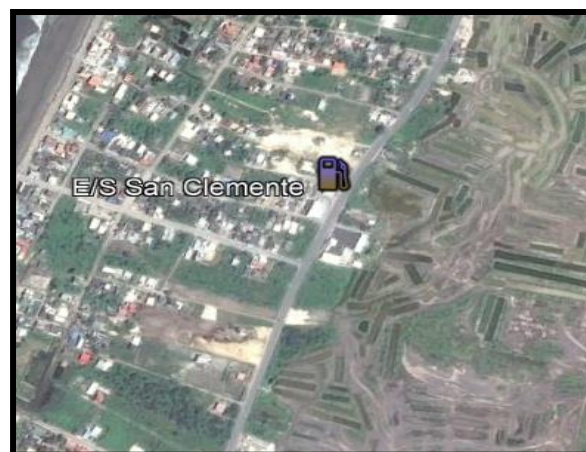
Fig 51 Vista general de la zona de emplazamiento de la E/S.
