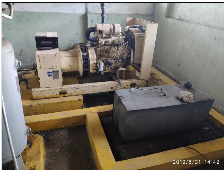
Imagen 10: Generador Emergente.
