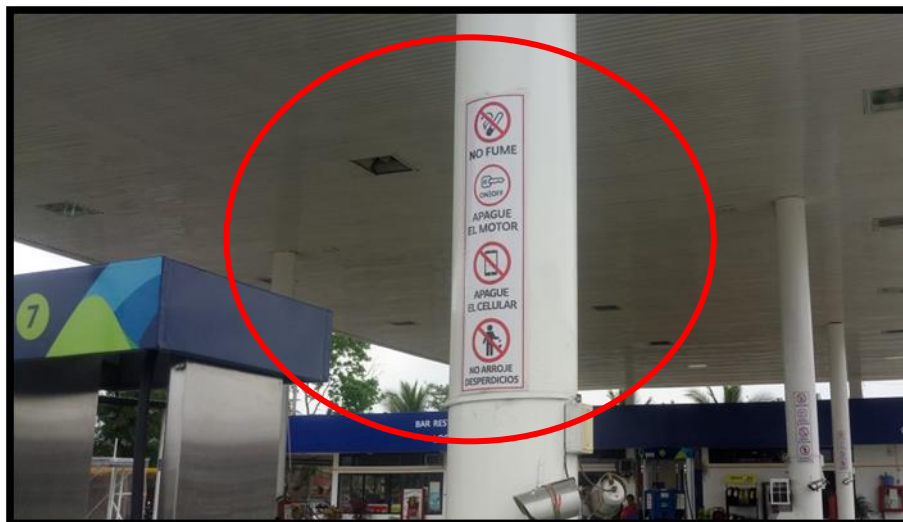
Fig. 37 Señalética en el área de despacho
