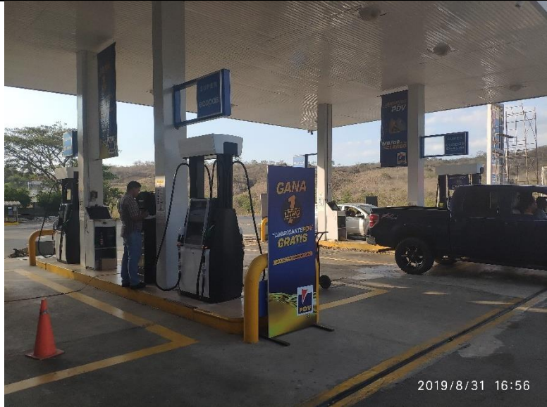
FOTO 13. BOCAS DE LLENADO.
