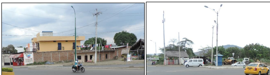
Fotografía 1. Infraestructura observada en el AID de la estación de servicios
