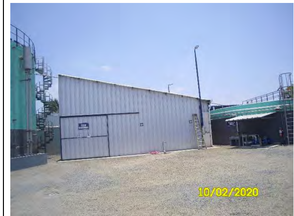
Fotografía 20: Las instalaciones de IROTOP S.A. cuenta con señalética iluminadas que permitan su fácil identificación.
