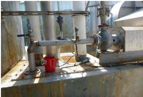
Fotografía 1. Punto de monitoreo
