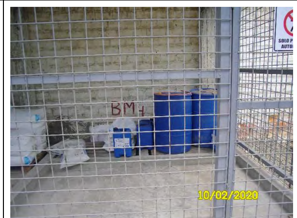
Fotografía 12: Almacenamiento de sustancias peligrosas. Superficie continua e impermeable separada por cubetos.
