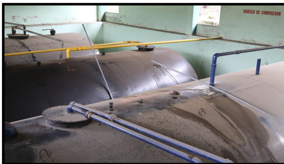
Fig. 36 Tanques subterráneos de almacenamiento de combustible E/S SIND. CHOF. CALCETA Esta zona cuenta con la pinza a tierra para evitar que pudieran producirse incidentes durante la descarga. Así como los tanques de almacenamiento de la estación cuentan con tubos de venteo que permiten la adecuada difusión de gases.
