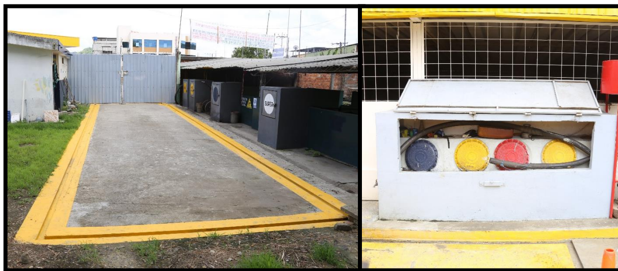
Fig 34. Área de descarga de combustibles – Boca tomas Descripción de operación y mantenimiento de trampas de grasas
