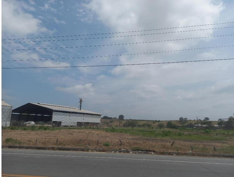
Foto 8-1 Área de construcción de la estación de servicio Fuente: Levantamiento de Campo, julio 2022 Realizado por: Grupo Consultor, julio 2022.
