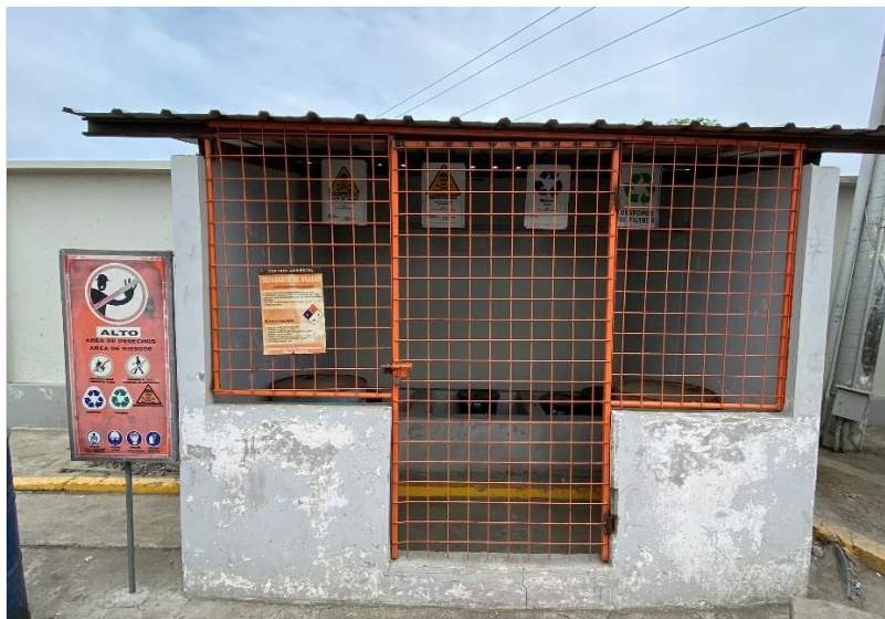
Figura 10. Bodega de desechos peligrosos
