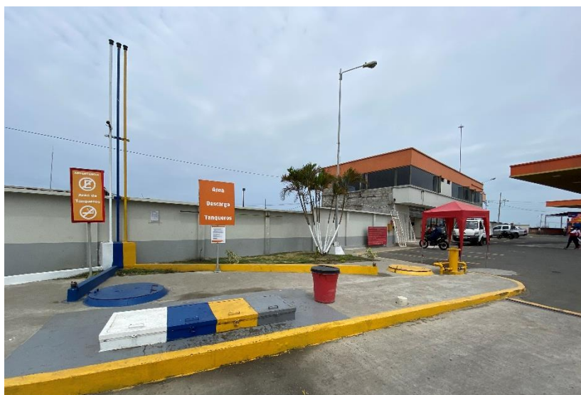
Figura 8. Área de descarga de tanqueros
