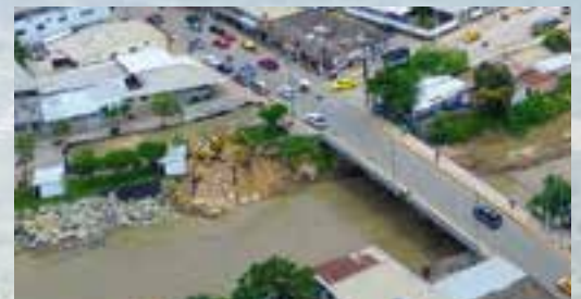
Limpieza y desazolve del Río Chone.
