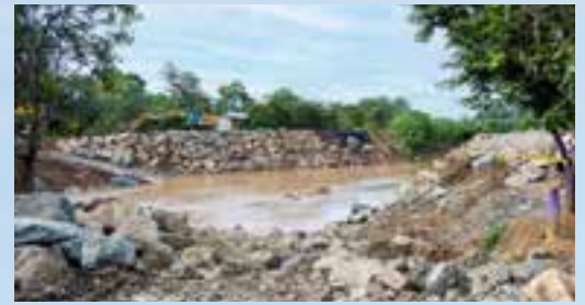
Protección de muros y badenes en el sitio El Mate del Río Garrapata.
