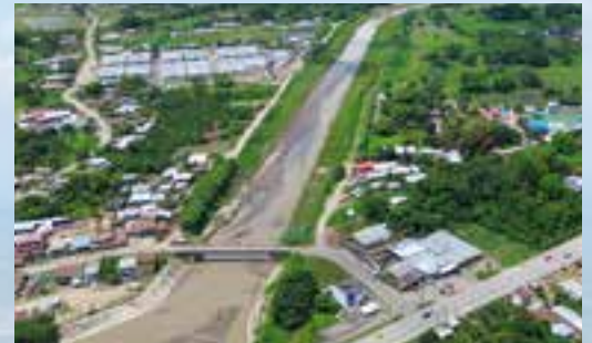
Canal de encauzamiento del Río Chone.
