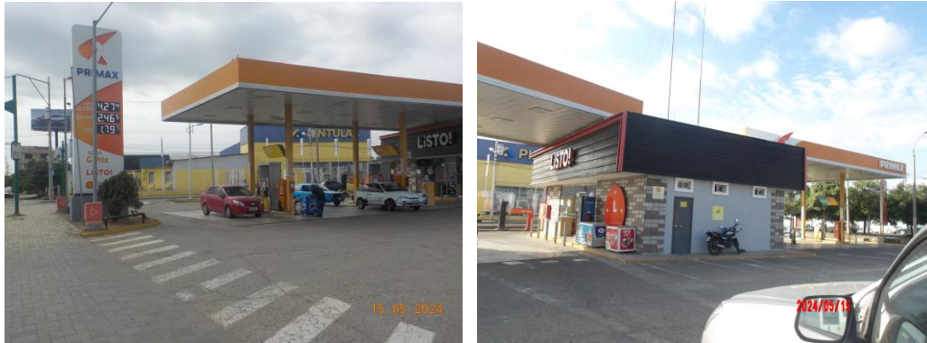
Fotografía 10.- Área de despacho y Circulación.
