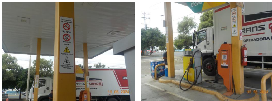
Fotografía 11.- Señalética del área de despacho y surtidores.
