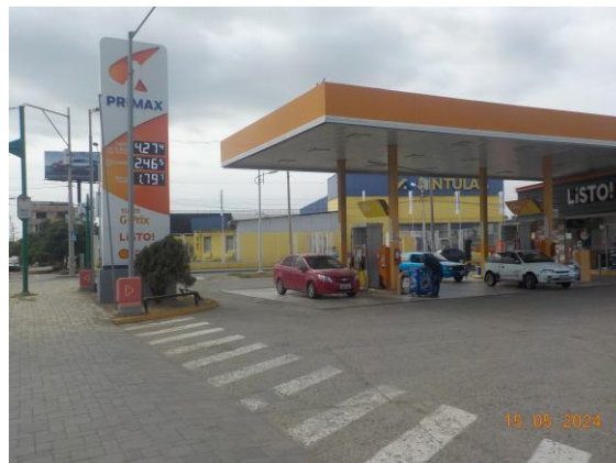
Fotografía 1.- Vista frontal Estación de Servicio “Manta”
