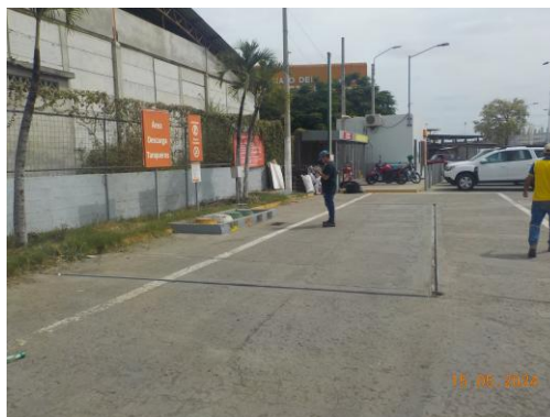
Fotografía 1.- Vista exterior del área de tanques de almacenamiento de combustible
